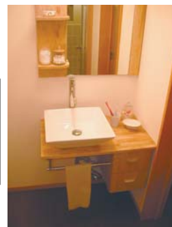
陶器製の流しを設置、手間をかけて作り込んだ洗面化粧台
